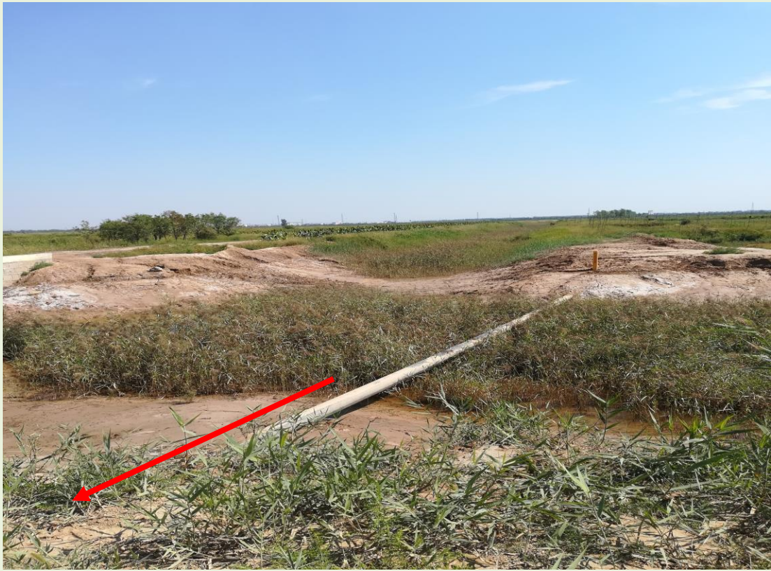
顶管穿越新义路
