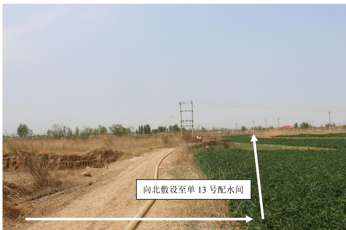
图 5.1-11 单 13 号站注水干线走向现场图 5
