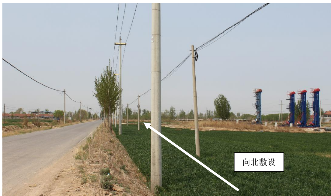
图 5.1-7 单 13 号站注水干线走向现场图 1
